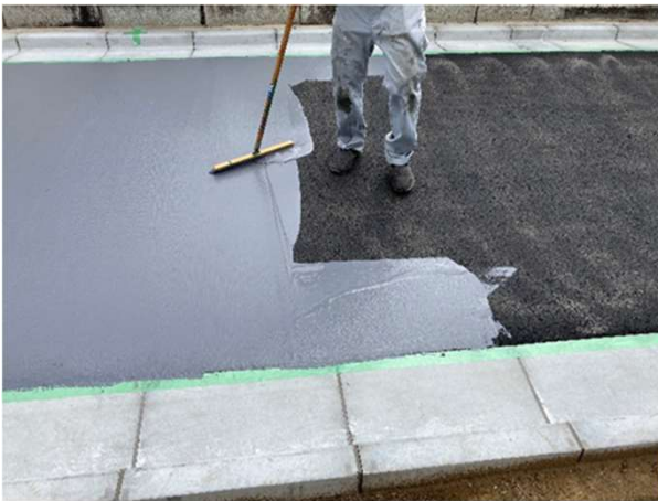
ミラクールロードW \alpha 施工状況 (塗布色:濃灰、密粒舗装の例)
