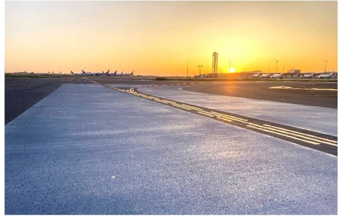
羽田空港 誘導路
