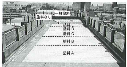
写真1 小学校屋上面
